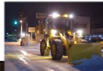
↑道路の機械除雪状況
